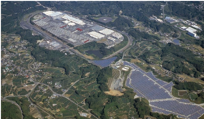
スズキ牧之原太陽光発電所
