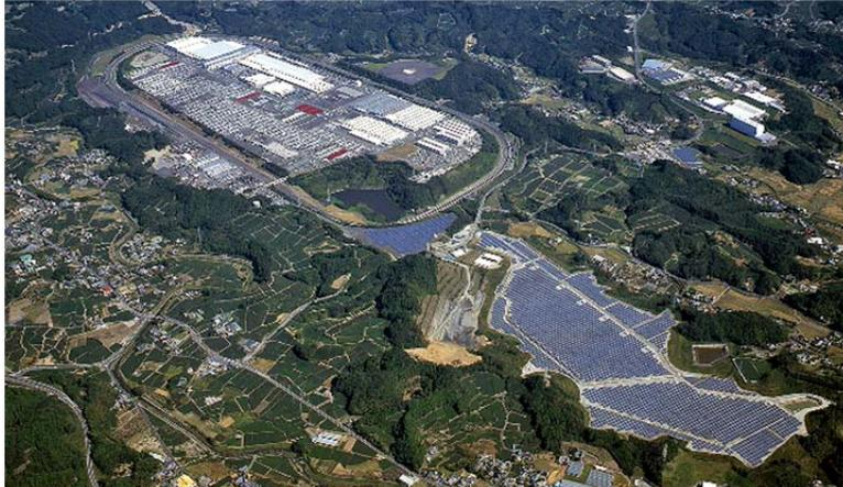
スズキ株式会社が静岡県牧之原市の中里工業団地に建設を進めていた太陽光発電施設「スズキ牧之原太陽光発電所」は、最大能力 20MW（メガワット）の発電所として昨年 10 月より試験運転を開始している。現在、発電量を更に増加させるための増設工事を実施しており、完成は 2016 年 7 月末を予定している。
