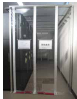
〈アイルキャッピング施工例〉
