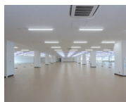
LED照明機器の設置
