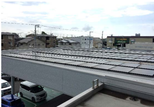
太陽光パネルの設置 (千葉県・(株)スズキ自販京葉)
