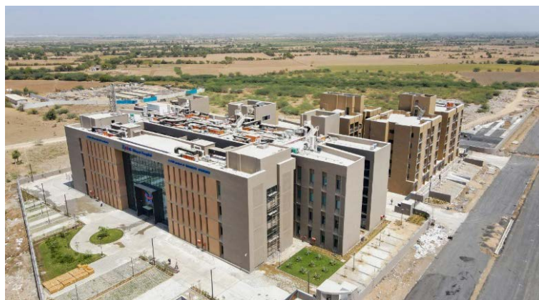
グジャラート州に総合病院を建設(インド)
