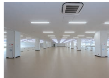
LED照明の導入
