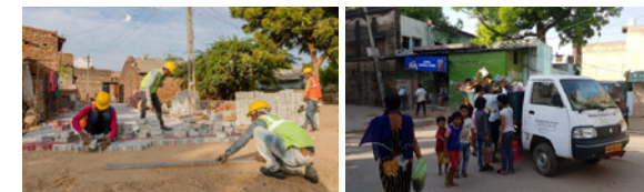
村の道路を舗装する様子
