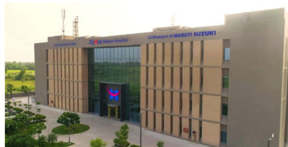
シタプル総合病院 外観 (グジャラート州シタプル)
