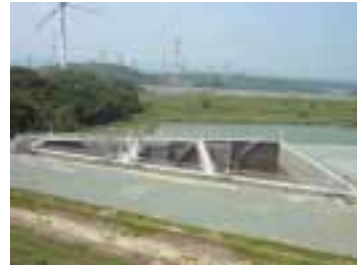
湖西工場・緊急貯留槽(容量：4,800m 3 )
