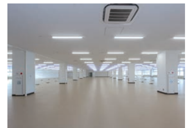
LED照明の導入
