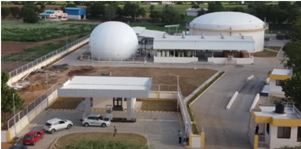
Banas Dairy社バイオガス精製プラント （このプラントを基にBanas Dairy社と当社が共同で4つのプラントを建設中）
