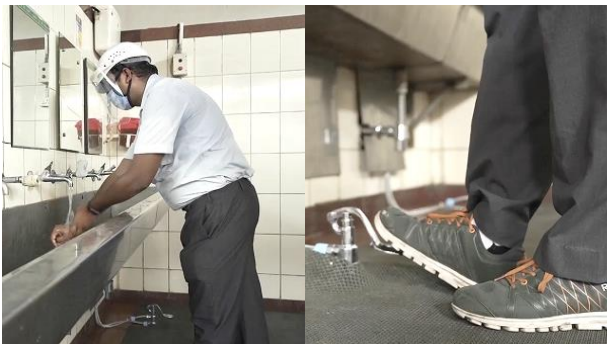
足踏み式水道の設置
