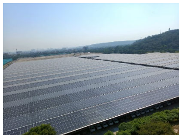
マネサール工場のモータープールの頭上に設置したソーラーパネル
