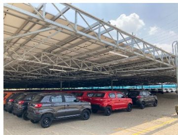
マネサール工場のモータープールの頭上に設置したソーラーパネル
