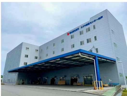
スズキ部品センター神戸の外観
