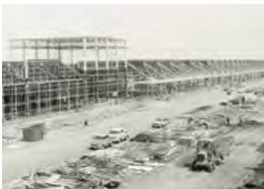
1967年 磐田工場建設中
