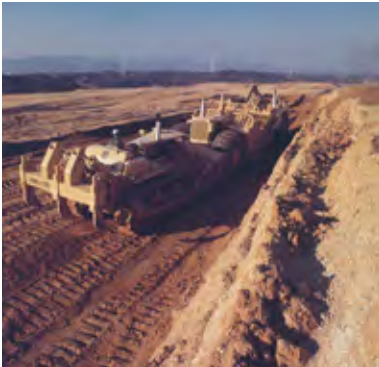
1969年 湖西工場 土地造成中
