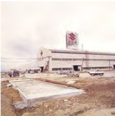
1970年 湖西工場建設中
